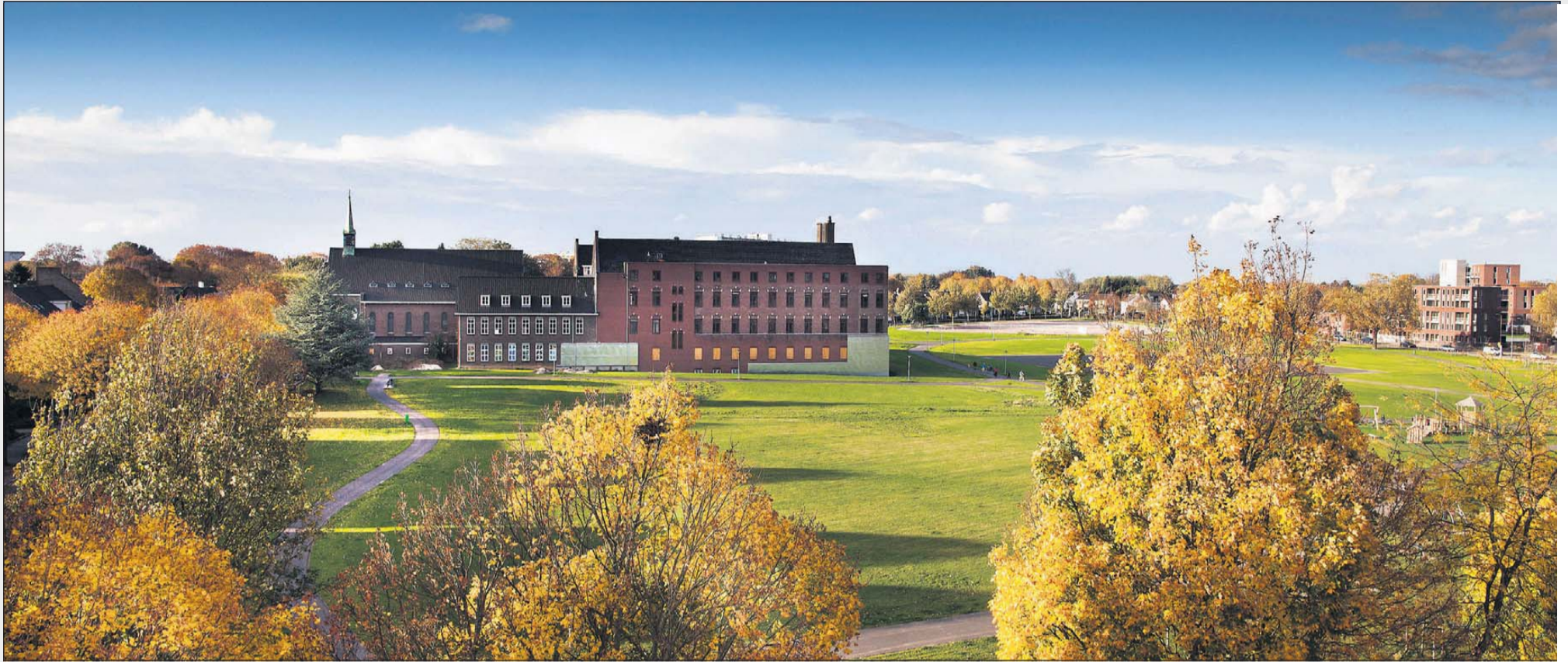
Het Franse Klooster in Sittard. Het rechter deel gaat tegen de vlakte voor de bouw van een ondergrondse parkeergarage. Later wordt dit deel opnieuw gebouwd.
